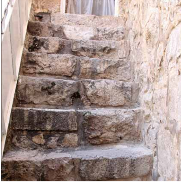
دار الزعتري - حارة بني دار بتاريخ 2006/8/3م وتبين مطلع درج من الجهتين الأمامية والخلفية محمول على قوس مع المحافظة على حجارة القوس القديمة مع ترميم حجارة الدرج نفسه تم استبدال النالف بالجديد
