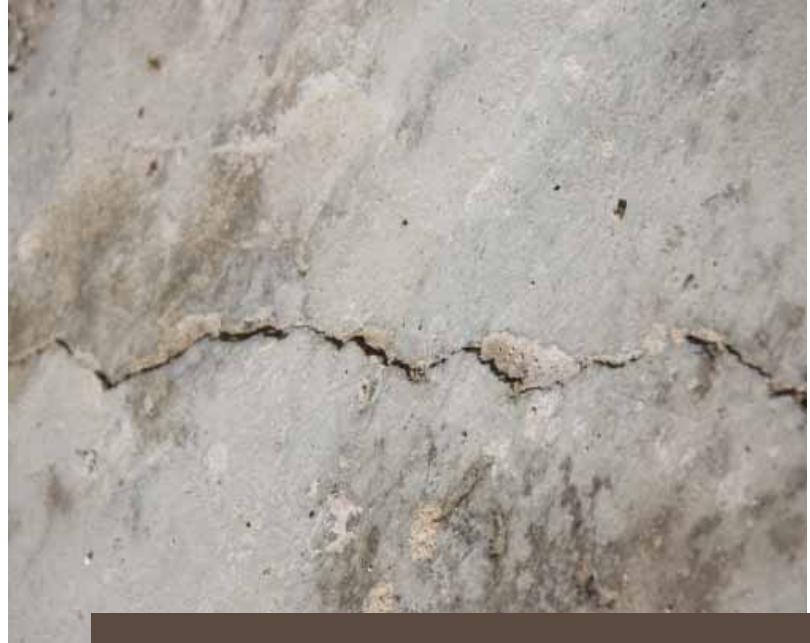
صورة توضح التلف الحاصل في مدة اسمنتية على احد اسطح البلدة القديمة
