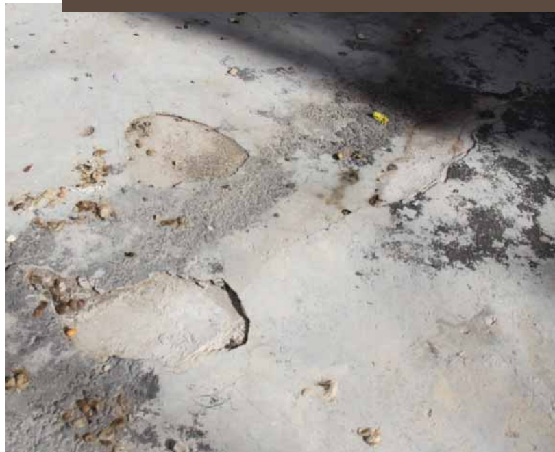
صورة توضح التلف الحاصل في مدة اسمنتية على احد اسطح البلدة القديمة
