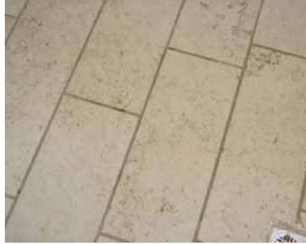
حوش شتي في حارة العقابة بتاريخ 2006/8/7 استخدام بلاط ارضيات مشابهه للبلاط الاصلي
