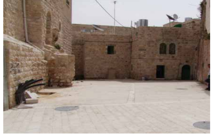
دار الكركي - حارة العقابة بتاريخ 2006/8/3 وتبين ساحة مكشوفة خارجية بعد عملية الترميم وقد استبدل البلاط الحجري القديم ببلاط جديد مشابه له .
