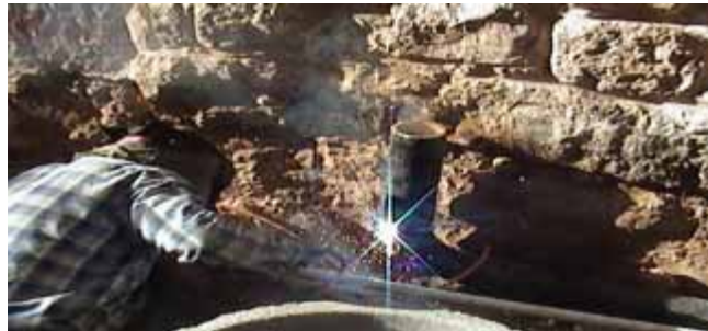
أعمال تمديدات مياه الشرب
