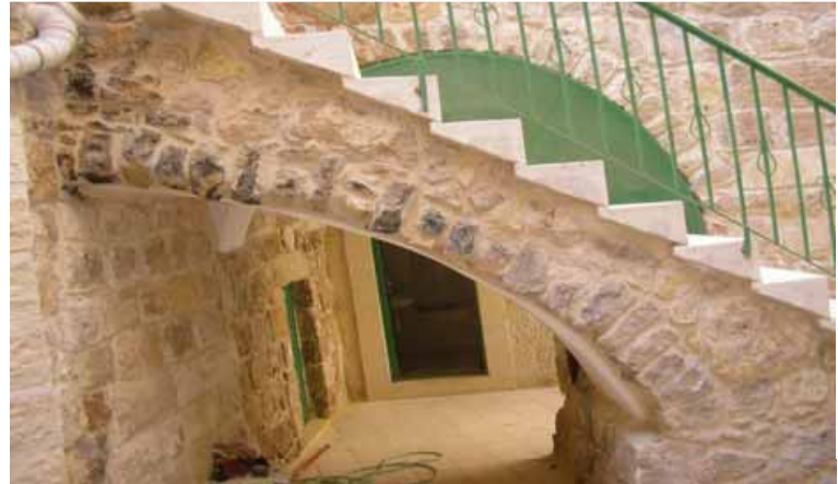
دار الزعتري - حارة بني دار بتاريخ 2006/8/3م وتبين مطلع درج من الجهتين الأمامية والخلفية محمول على قوس مع المحافظة على حجارة القوس القديمة مع ترميم حجارة الدرج نفسه تم استبدال النالف بالجديد
