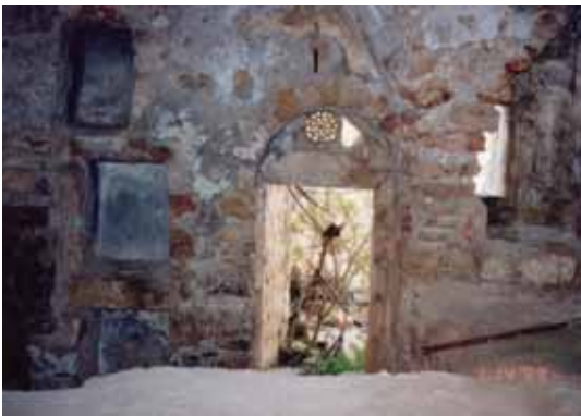
صور من بيوت البلدة القديمة في الخليل تظهر تساقط طبقات القصارة نتيجة عوامل عديدة
