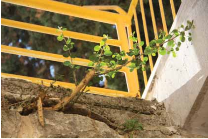
صور تبين نمو الاشجار في مباني البلدة القديمة في الخليل مما يؤدي الى تصدعها وانهيارها
