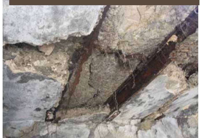
صور توضح مشكلة التلف الحاصل في عقدات الجسور المعدنية
