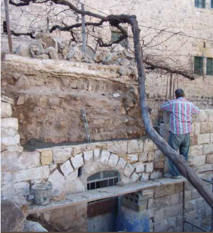
صورة توضح جدار مهدوم أثناء عملية الترميم وبعدها
