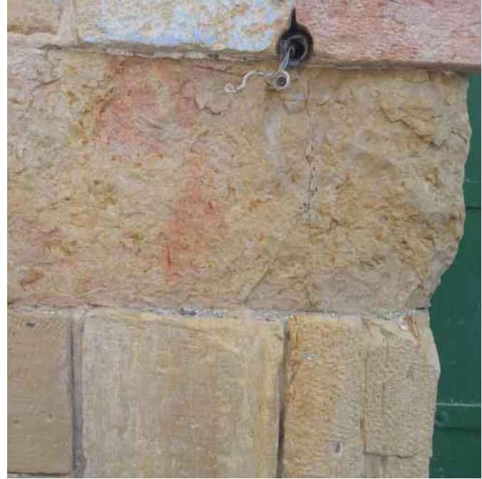
صور من البلدة القديمة في الخليل توضح ظاهرة اهتراء وجه الحجر
