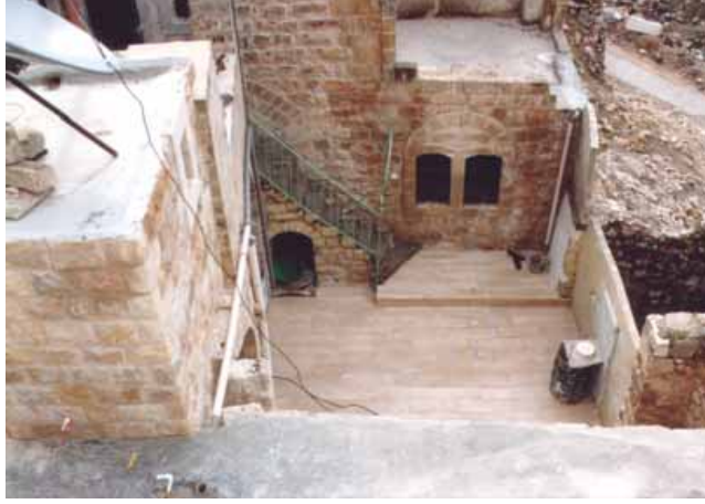
دار الكركي - حارة العقابة بتاريخ 2006\8\3 وتبين ساحة مكشوفة خارجية بعد عملية الترميم وقد استبدل البلاط الحجري القديم ببلاط جديد مشابه له .
