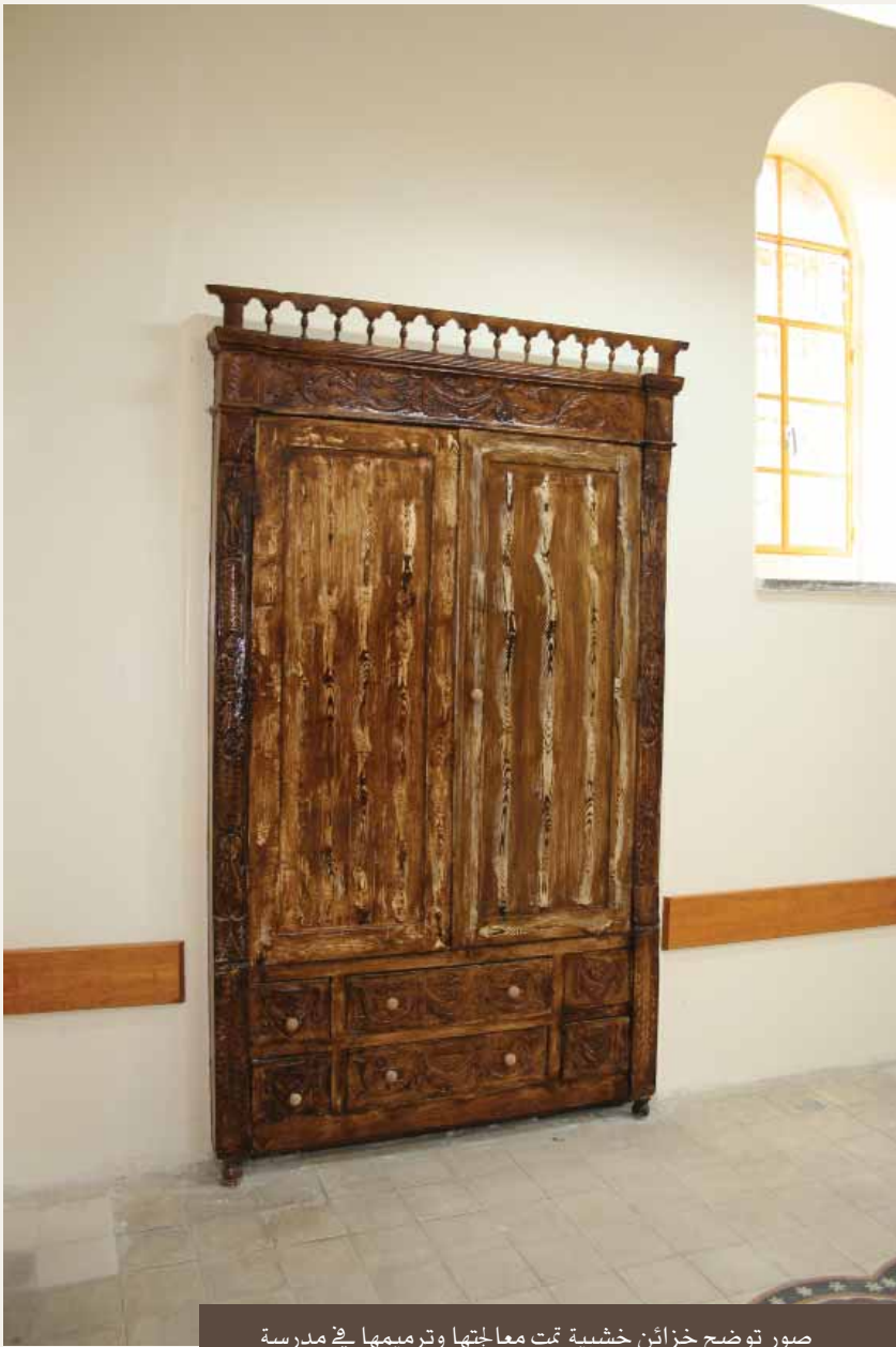
صور توضح خزائن خشبية تمت معالجتها وترميمها في مدرسة شجرة الدر الاساسية في البلدة القديمة
