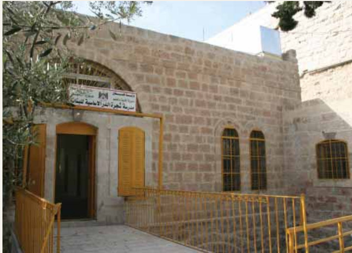
صورة لأعمال الحديد بعد إصلاحها في مدرسة شجرة الدر في البلدة القديمة
