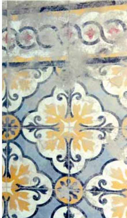
حوش شتي في حارة العقابة بتاريخ 2006/8/7 استخدام بلاط ارضيات مشابهه للبلاط الاصلي
