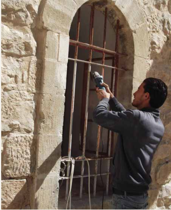
صور لعامل يعمل على صيانة الحماية الحديدية لشباك في البلدة القديمة
