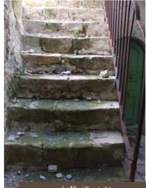
صورة توضح تلف الأدرج بسبب الاستعمال المتكرر
