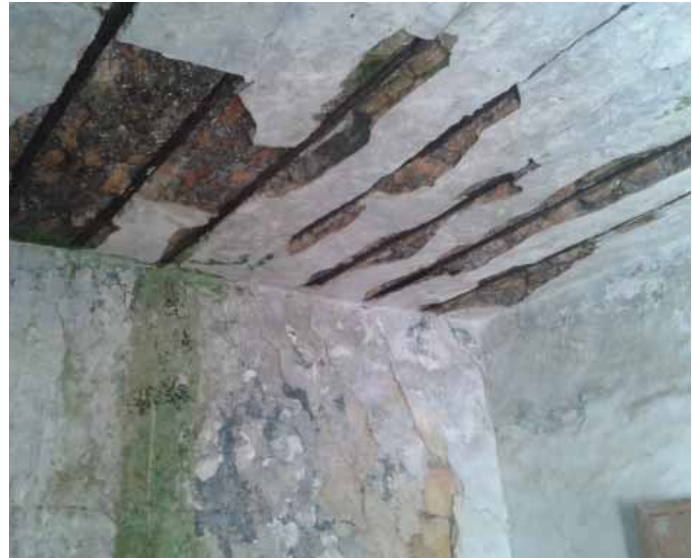
صور توضح مشكلة التلف الحاصل في عقدات الجسور المعدنية
