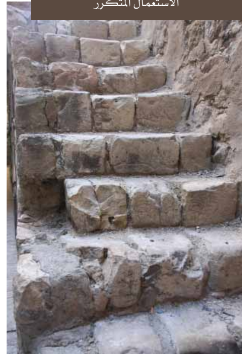
صورة توضح تلف الأدرج بسبب الاستعمال المتكرر
