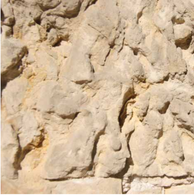
صور من البلدة القديمة في الخليل توضح ظاهرة اهتراء وجه الحجر
