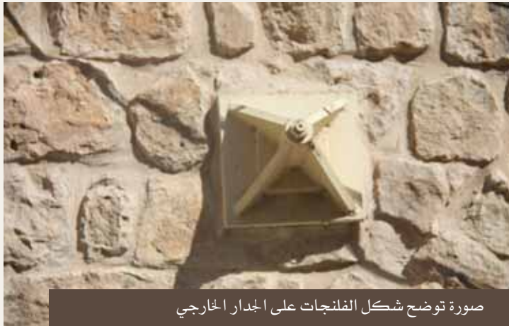
رسم توضيحي يبين عملية تريبط المبنى بواسطة الفلنجات
