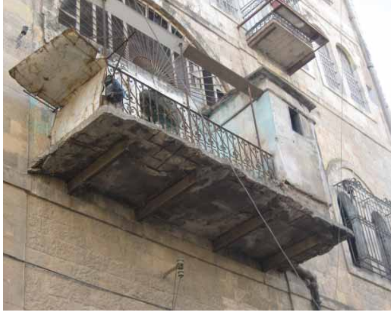
صور توضح مشكلة التلف الحاصل في عقود البرندات الخارجية
