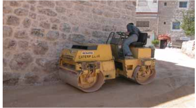
أعمال فرد ودحل طبقات البيسكورس
