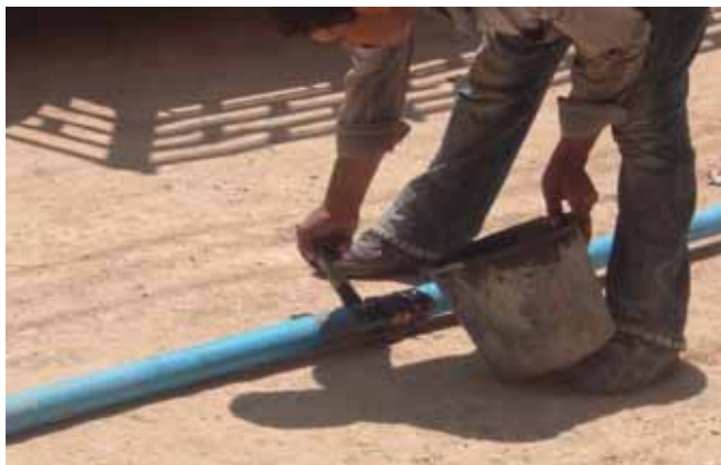
أعمال تمديدات مياه الشرب
