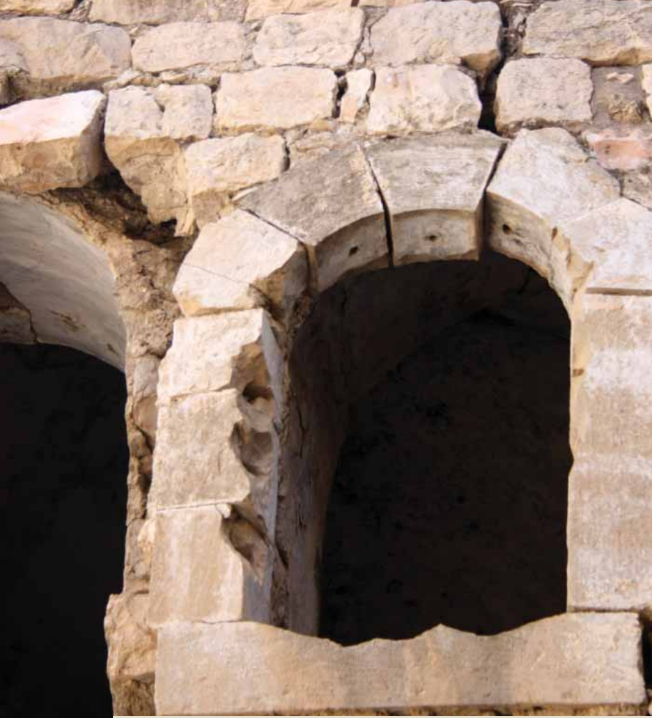
صور من البلدة القديمة للخليل توضح مشكلة القطع الحجرية المتكسرة
