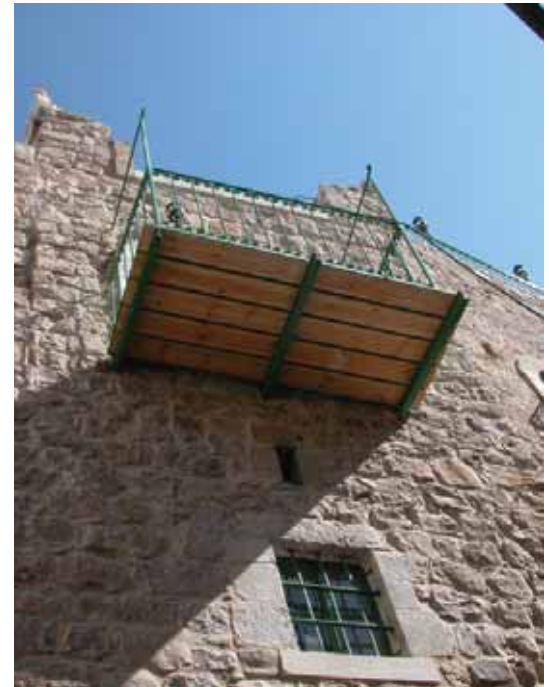
صورة توضح البرندات المرممة في مبنى الشريف
