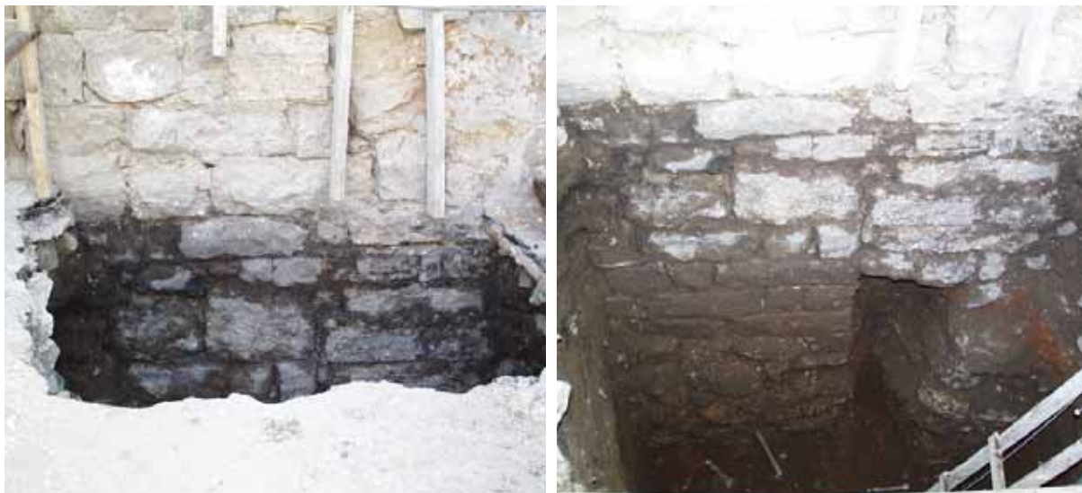
صور من مبنى قصر الدويك توضح عملية حفر التربة بجانب الجدار الاستنادي
