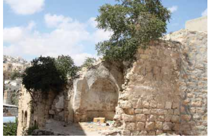
صور تبين نمو الاشجار في مباني البلدة القديمة في الخليل مما يؤدي الى تصدعها وانهيارها
