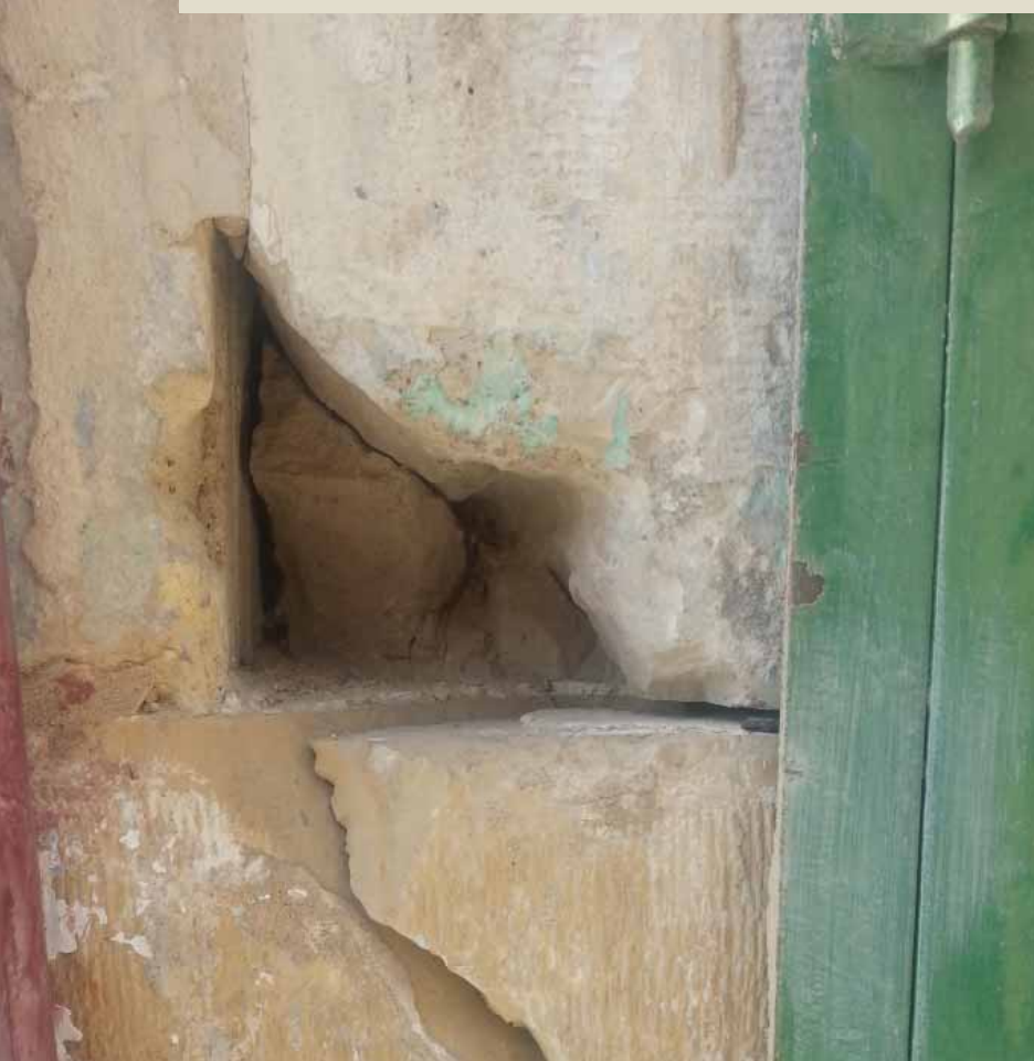
صور من البلدة القديمة للخليل توضح مشكلة القطع الحجرية المتكسرة
