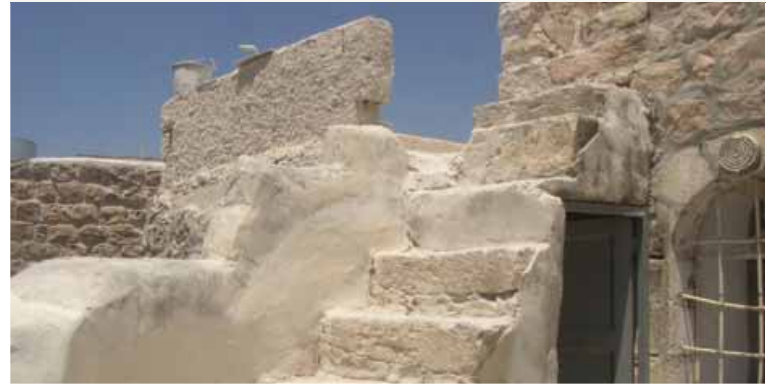
دار الزعتري - حارة بني دار بتاريخ 2006/8/3م وتبين مطلع درج من الجهتين الأمامية والخلفية محمول على قوس مع المحافظة على حجارة القوس القديمة مع ترميم حجارة الدرج نفسه تم استبدال النالف بالجديد
