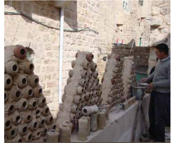
صورة لعمال أثناء العمل على ترميم المشربيات في مبنى مرقّة
